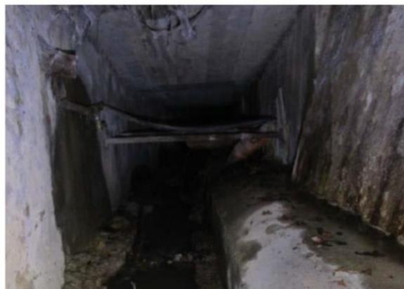
Figure 11 : État actuel du voûtage et du collecteur des eaux usées nécessitant leur remplacement
