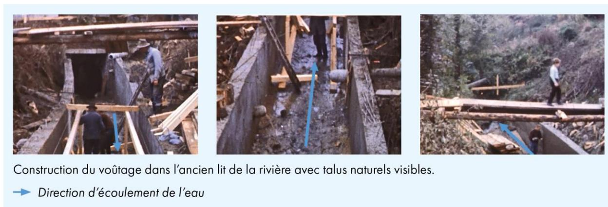
Figure 3: Photos illustrant la construction du voûtage dans sa partie amont en 1961
